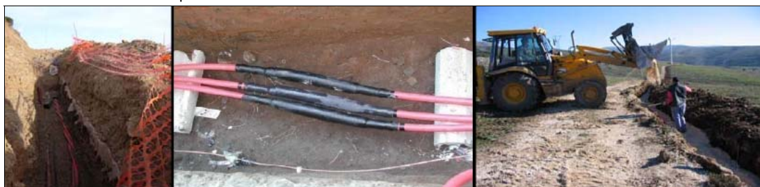
Figura 3: Esempio di scavo con posa cavi
