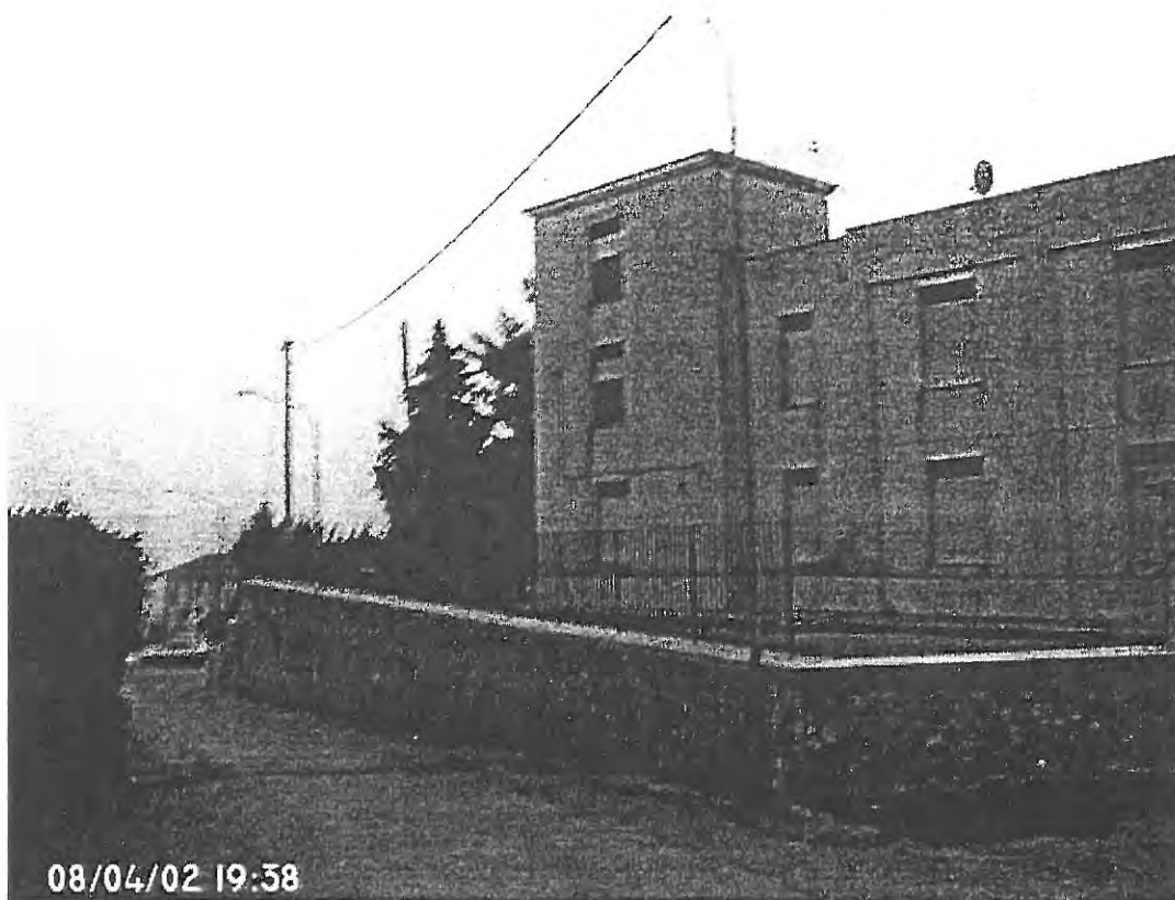
Figura 5 - Sito di cui al rilievo n.6 (Edificio scolastico)
